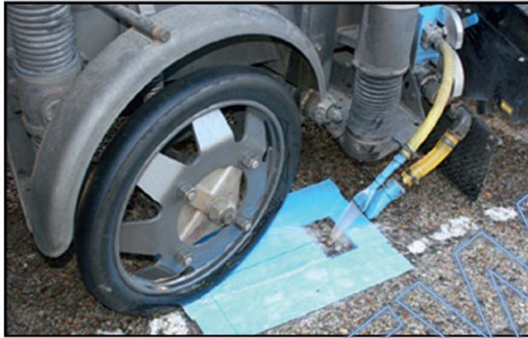
Comprobación del caudal vertido.
